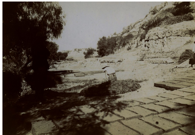
Fig. 5 – Fabrication d'adobes (NM)
